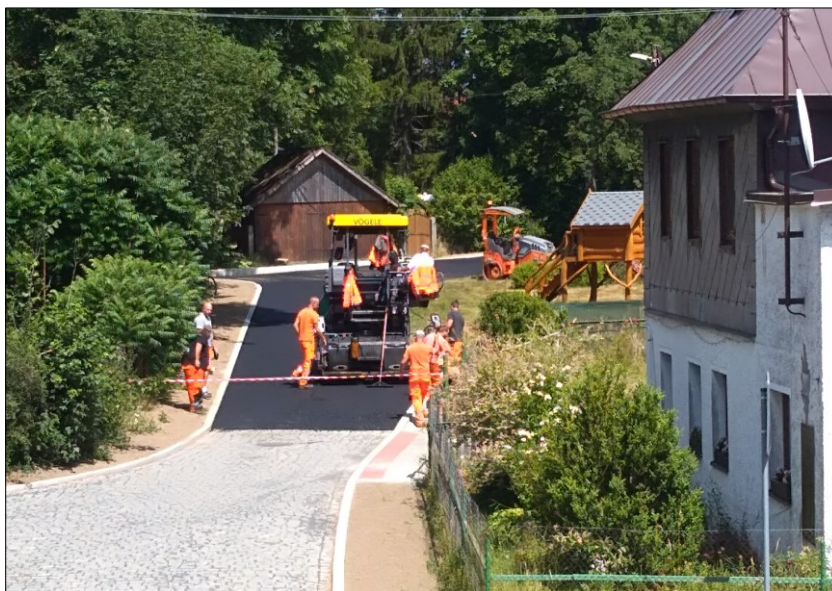
Práce na příjezdové komunikaci - foto D. Strnadová
