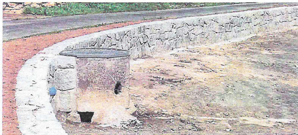
Foto nahoře : celkový pohled, foto dole : detail zídky. Nafotila a sepsala : D. Strnadová
