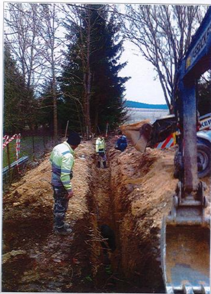
Na obrázku jsou zachyceny výkopové práce naproti domu pana Martina Jirmana
