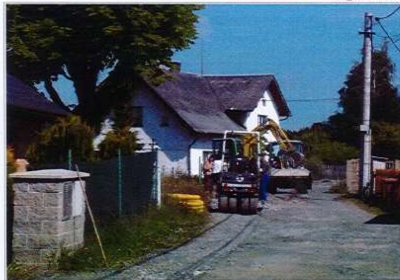
Začátek stavby – červenec 2013
