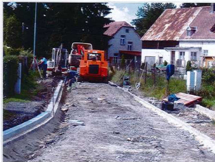
Foto : práce v úseku od Zadranských směrem k domu Puterových
